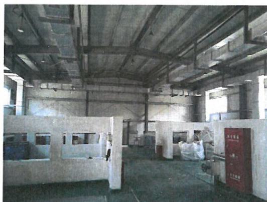
危废暂存库（内）
