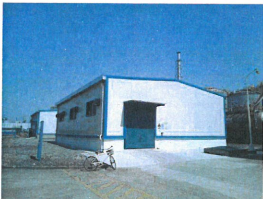
危废暂存库（外）
